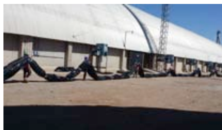
Preparación de las lonas.
